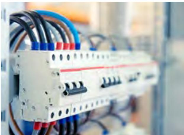
Die Easy-Entry-Isolierung ermöglicht schnelles Einführen der Leiter, ohne dass diese aufspießen.
