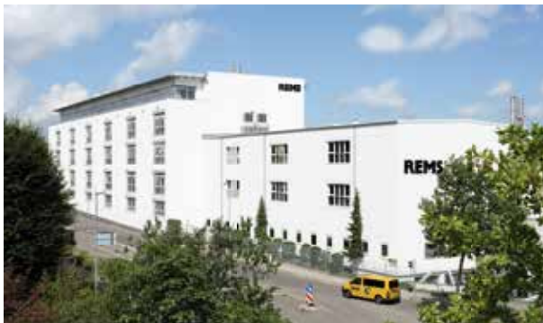
REMS Schulungszentrum in Waiblingen bei Stuttgart.
